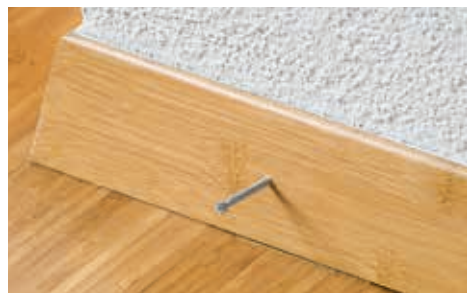
Fixation de plinthes
