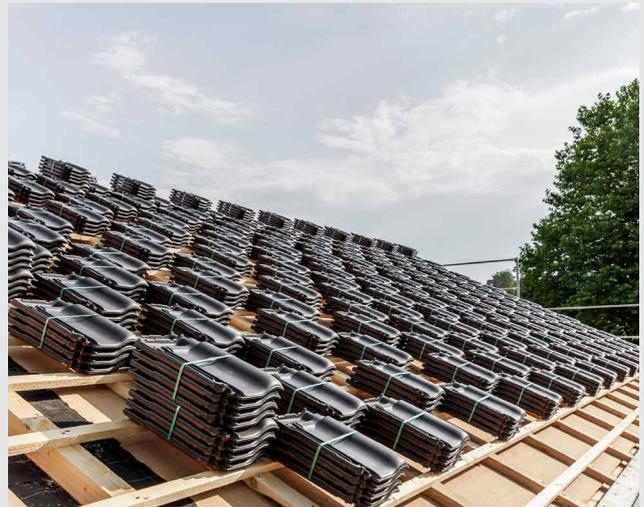
**Exemple de charge de matériaux de couverture**
