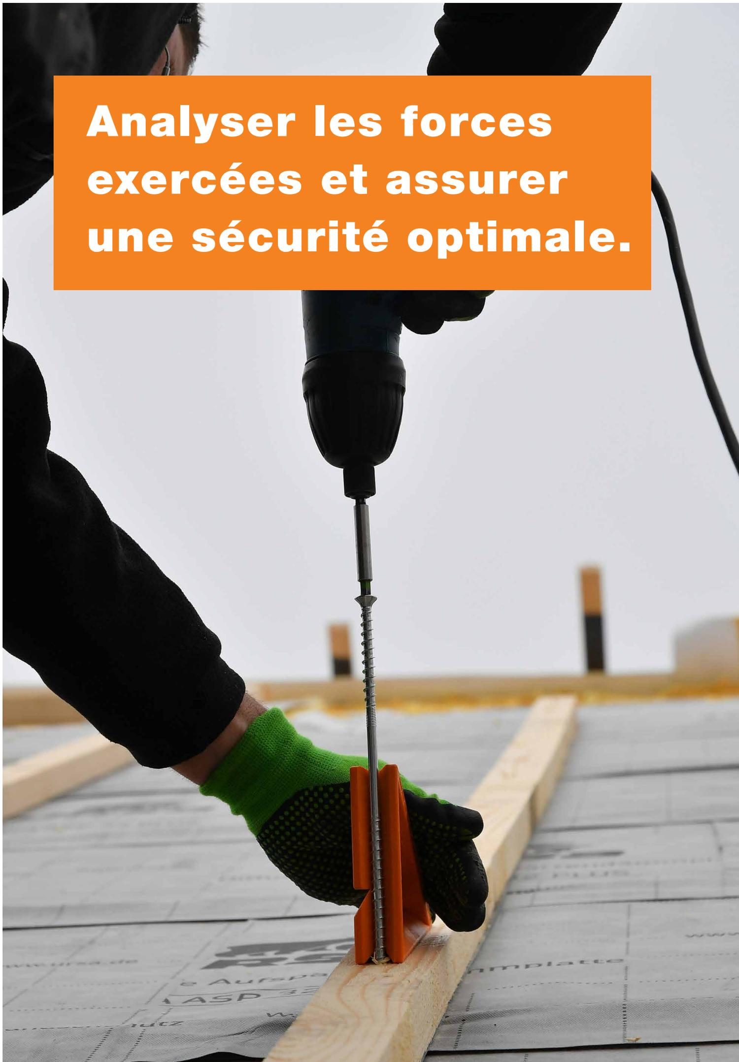
Lors de l'exécution et la planification de projets d'isolation de toiture, on doit tenir compte de différents aspects. Les forces exercées sur un toit par son propre poids, la neige et le vent (force de cisaillement et de poussée) peuvent être verticales ou perpendiculaires. Elles doivent être évaluées individuellement pour chaque projet. Il convient de ne pas oublier les équipements supplémentaires comme les installations photovoltaïques ou les arrêts de neige.
